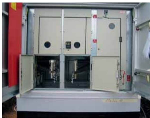
Abb. 4 MS-Schaltanlage Frontseite
