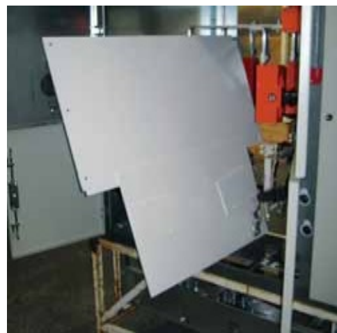
Abb. 13 Trennplatte
