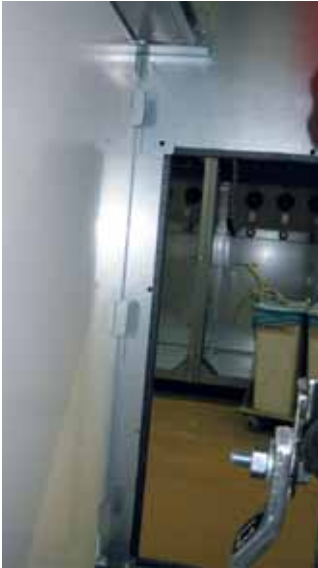
Abb. 14 Aufhängung Trennplatte
