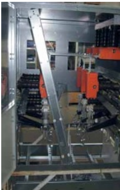
Abb. 10 Demont. Mittelsteg
