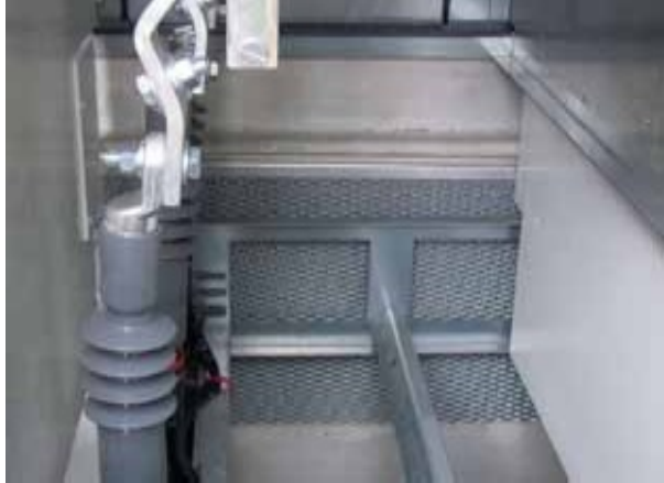
Abb. 16 Einfassung Streckmetallgitter
