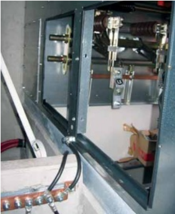
Abb. 5 MS-Schaltanlage Rückseite
