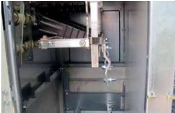
Abb. 17 Kabelhalteschienen
