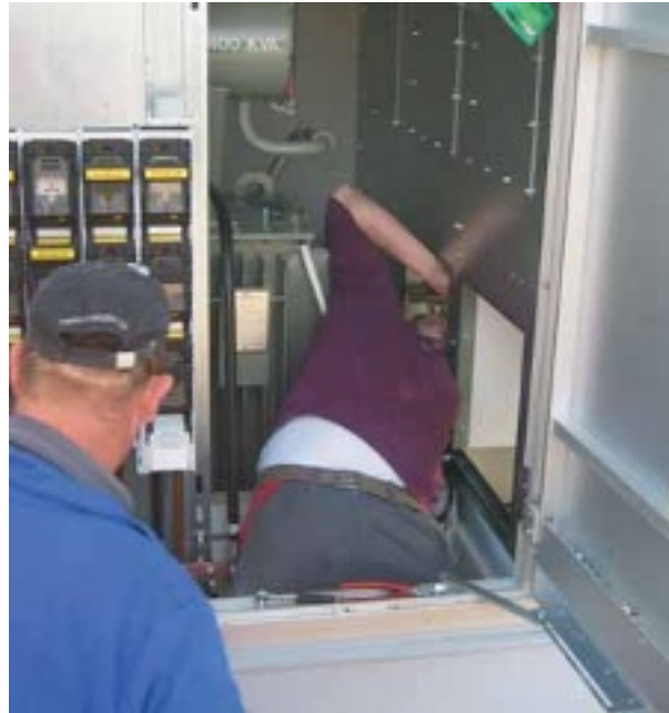
Abb. 7 Montage der Trennplatten
