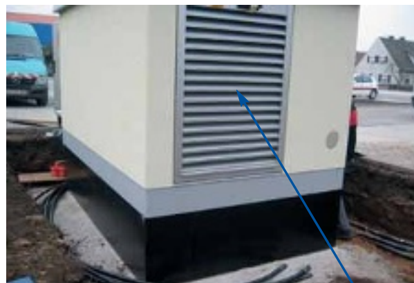
Abb. 2 Ansicht 20-kV-Kompaktstation
